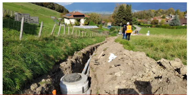
Création d'un réseau de transit d'assainissement entre Bellecombe et Bellecombette
